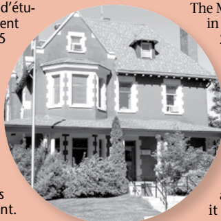
Bâtiment du CMEV MCSA building
