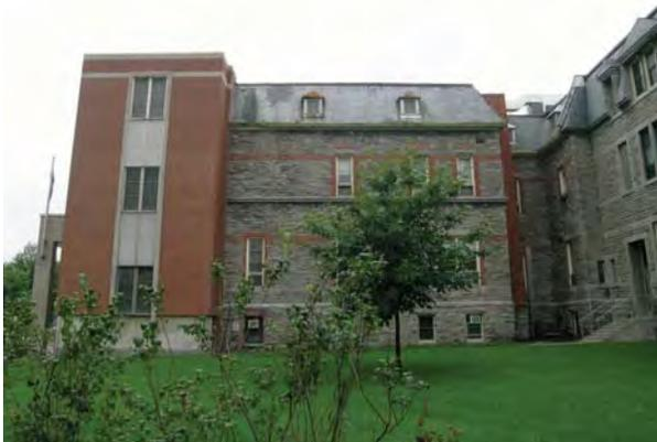
85. Détail montrant l'ajout d'une nouvelle façade à l'édifice d'origine. Source : EM-2006
